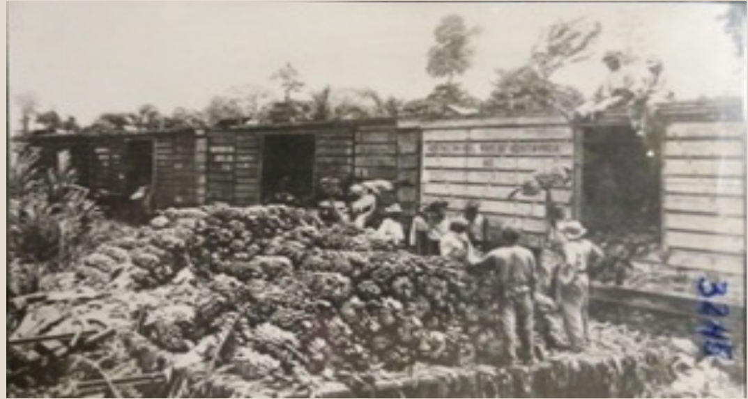
Fotografía de puerto Limón, vagones del ferrocarril y traslado de banano.
